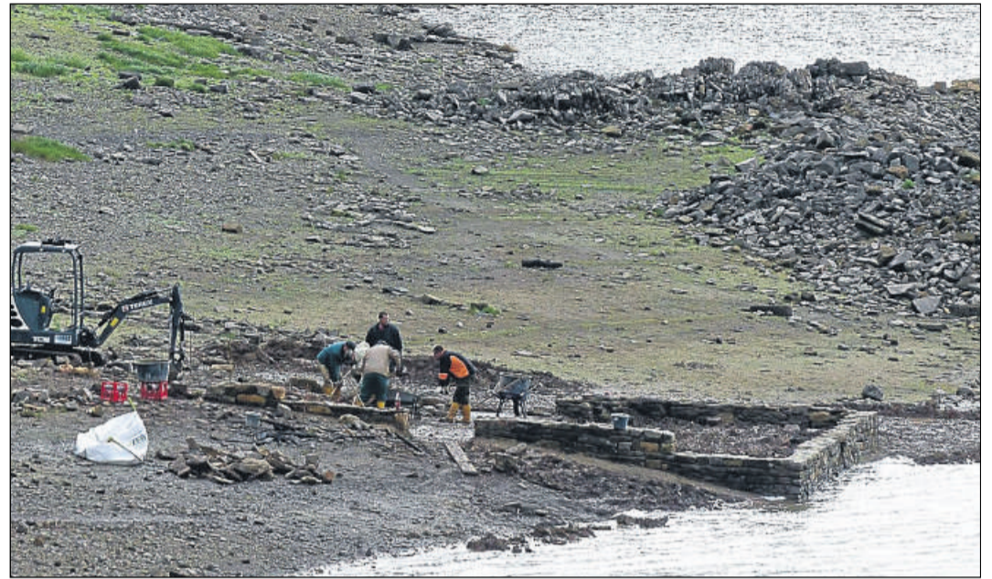
Wieder vom See verschluckt: Wegen des steigenden Wasserpegels mussten die Arbeiten an den Grundmauern des Wohnhauses Knüppel schnell zum Abschluss gebracht werden. Fotos: Göbel
